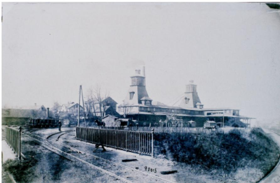
L'embranchement des puits Lucy vers 1880. On aperçoit le cheval de trait préposé à la manœuvre des wagons sous les trémies de chargement, et on notera le faible armement de la voie (Document La Mine et les Hommes ; DR).
