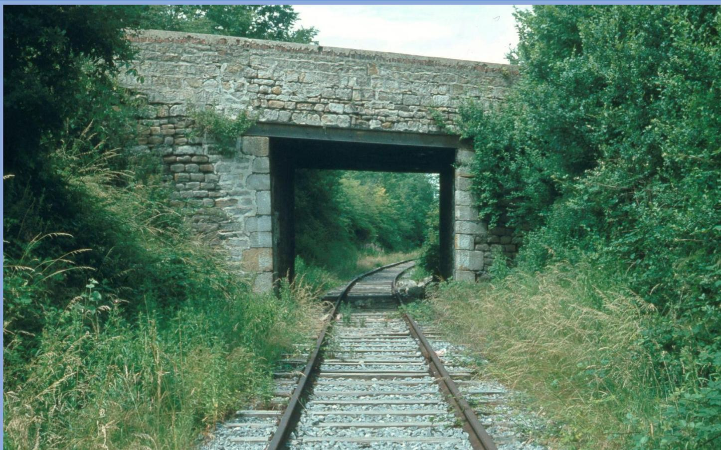
Chemin de fer de Sorbiers en 1980 à l'Eparre : le pont sous la rue Mathieu de la Drôme, avec ses pierres de taille d'origine, pont renforcé avec des poutrelles métalliques dans les années 1950, et avant sa reconstruction en béton armé vers 1990. Nous sommes dans la partie en tranchée correspondant à l'embranchement initial de Chaney datant de 1840 – Photographie Patrick Etiévant -
