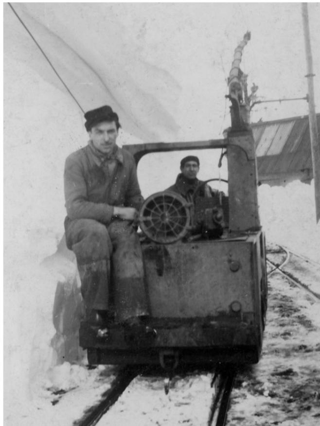
1 - Locomotive MF 32 (S.A.C.M.) ayant tracté un train de déblai sur la passerelle. Elle est équipée de sa perche d'origine (collection J. PINZONI).
