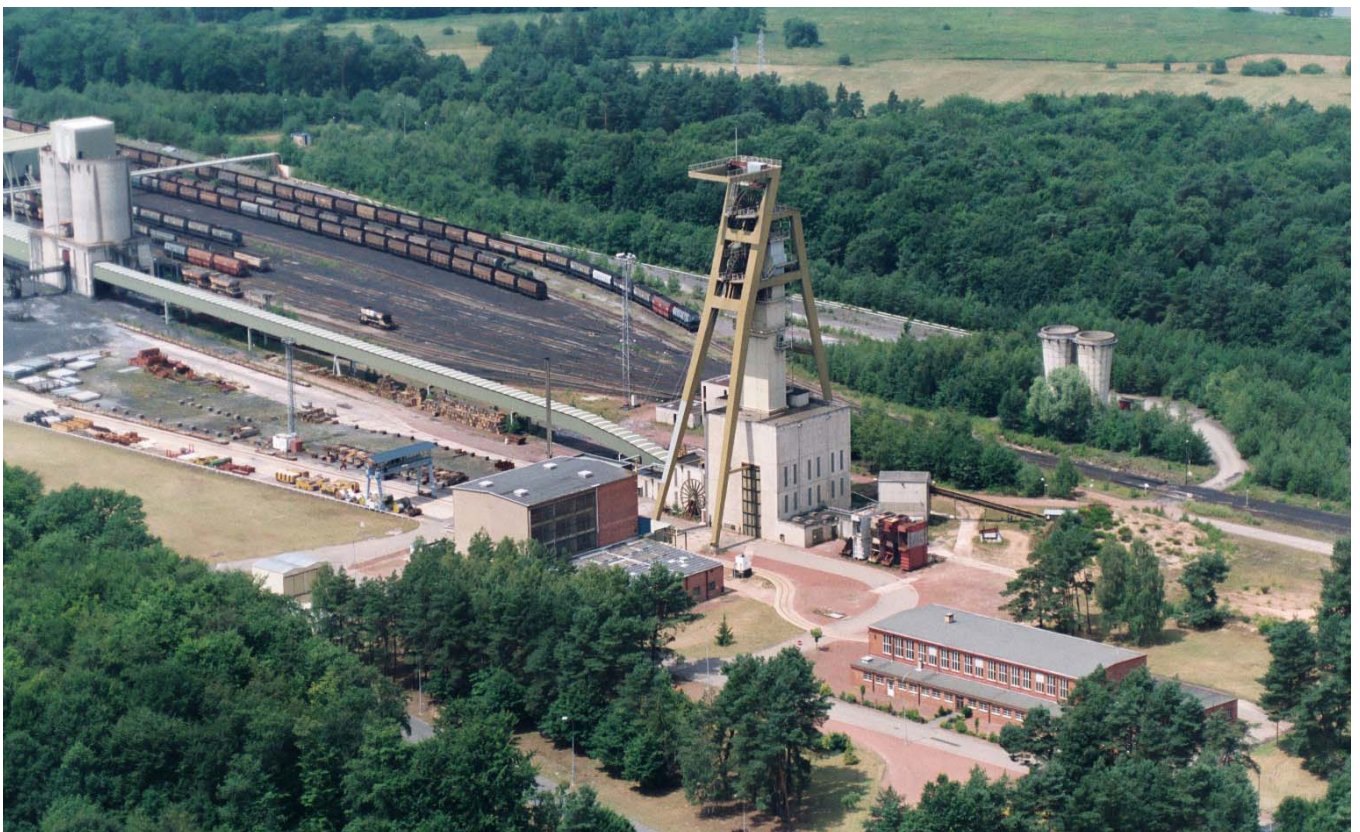
Le puits De Vernejoul - à l'avant du puis sur la droite les ventilateurs aspirants, à gauche le lavoir et le triage – photo HBL.
