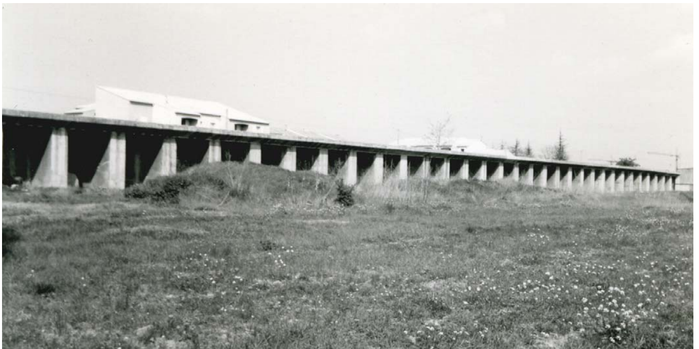
Le quai de transbordement du minerai à Brignoles, vu en juin 1990. Les villas voisines ne sont pas encore édifiées. Photographie Louis Caillot
