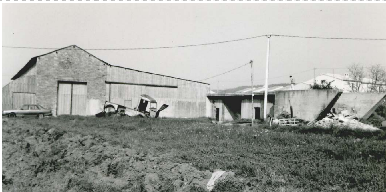
La remise en voie normale de Brignoles et le début du quai de transbordement en juin 1990. La rampe d'accès au quai est déjà disparue – Photographie Louis Caillot
