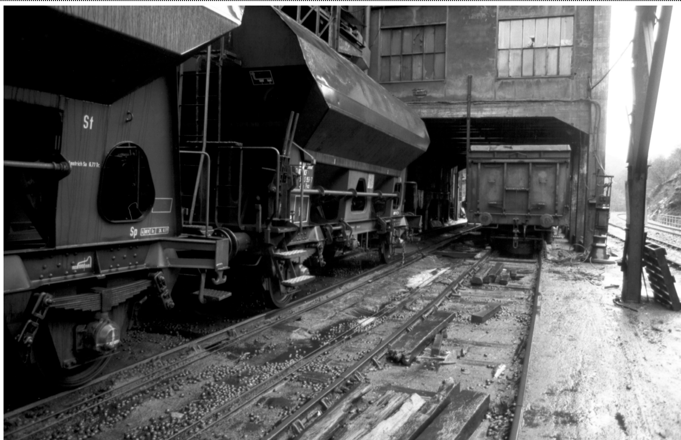
Le halage par câbles au Port Sec en 1979 (photographie Patrick Etiévant). On aperçoit les chaînes fixées au câble qui enserré le tampon du premier wagon trémie. Sur la droite se trouve un cabestan électrique.
