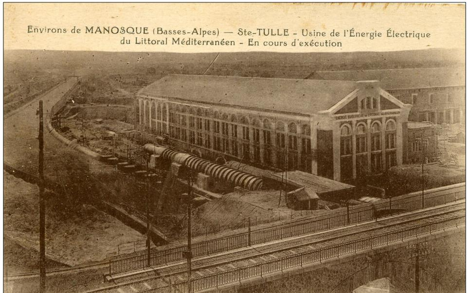
*La centrale hydraulique de Sainte-Tulle en construction. Au premier plan la ligne PLM de Grenoble à Marseille. Sur le second plan, la voie étroite joignant la base de travaux SGTM à la centrale. Collection P. CARENCO.*
