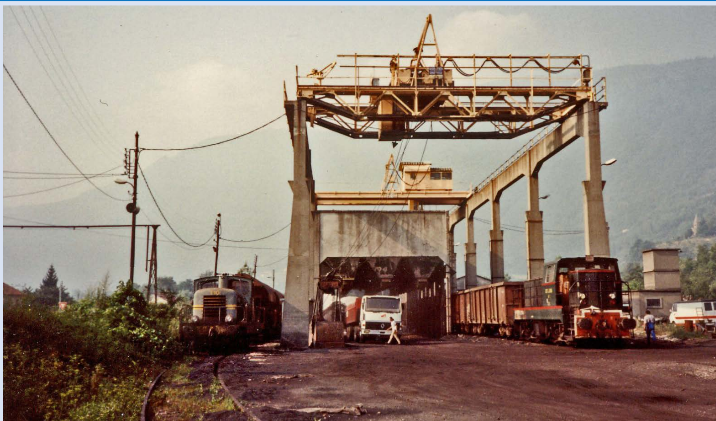
Vizille-Terrasse, fin des années 1980. A droite, sous l'imposant portique de transbordement équipé de deux ponts stationne une rame de wagons-tombereaux à boggies Eaos, tracteur ex-EL8 (toujours en livrée d'origine) en tête. A gauche, le locotracteur ex-VFD T10 est attelé à une rame de trémies Tds à deux essieux. Entre les deux, un ensemble routier VFT Renault en cours de chargement sous les trémies béton. Belle ambiance industrielle pour un ensemble alors en pleine exploitation ! Cliché Francis Perenon, collection Rail et Industrie.
