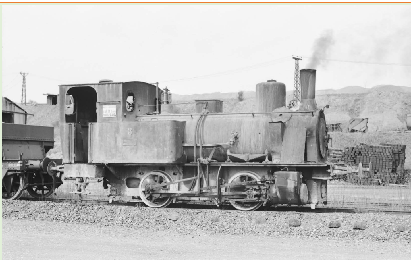
La locomotive n°3, 020T Henschel à Kassel, en voie normale. Elle arrive en 1933 via le revendeur Alsacien Tichauer. Cette machine a été construite en 1914 sous le n°13007. On note l'imposant stock de briquettes de charbon à l'arrière-plan, probablement en provenance de Blanzy ou de La Machine – Photographie Jacques-Henri Renaud - Collection Etiévant -
