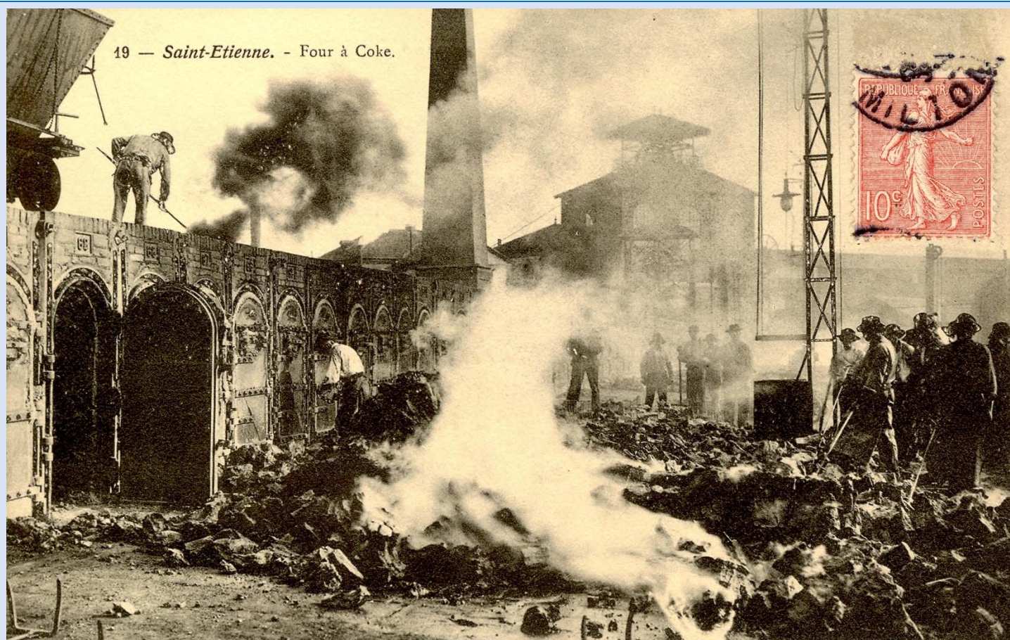
La compagnie des Houillères de Saint-Etienne (HSE) exploitait un gisement de charbon contenant beaucoup de matières volatiles (charbon à « gaz »). Il était réputé pour produire du coke sidérurgique. Nous assistons ici à l'extraction du coke du four n°69 de la cokerie des HSE à Méons. Au-dessus du four à gauche, on aperçoit un des wagons-trémie (« coal car ») qui va permettre le rechargement du four n°69 en houille. A l'arrière-plan, on reconnaît dans la fumée la silhouette du puits Verpilloux. Les ouvriers préparent le défournement de la cellule de cokéfaction n°65 - Collection Patrick Etiévant -
