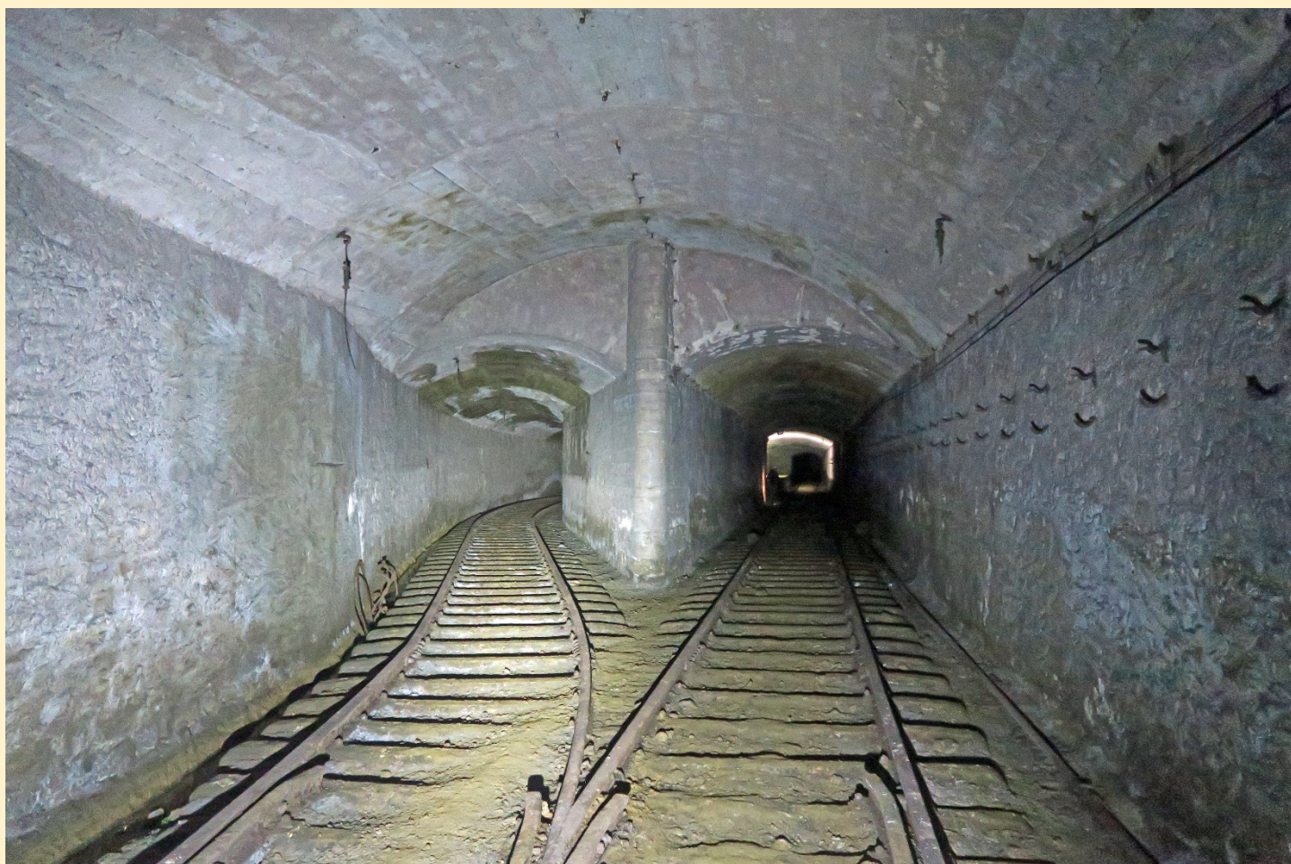
Vue réalisée dans le tunnel à voie normale creusé dans la couche noire. A droite la voie se dirigeant vers la gare d'Haméville (à la hauteur des lumières), à gauche la voie de retour de la locomotive permettant sa remise en tête de la rame de voitures - Patrick Etiévant -
