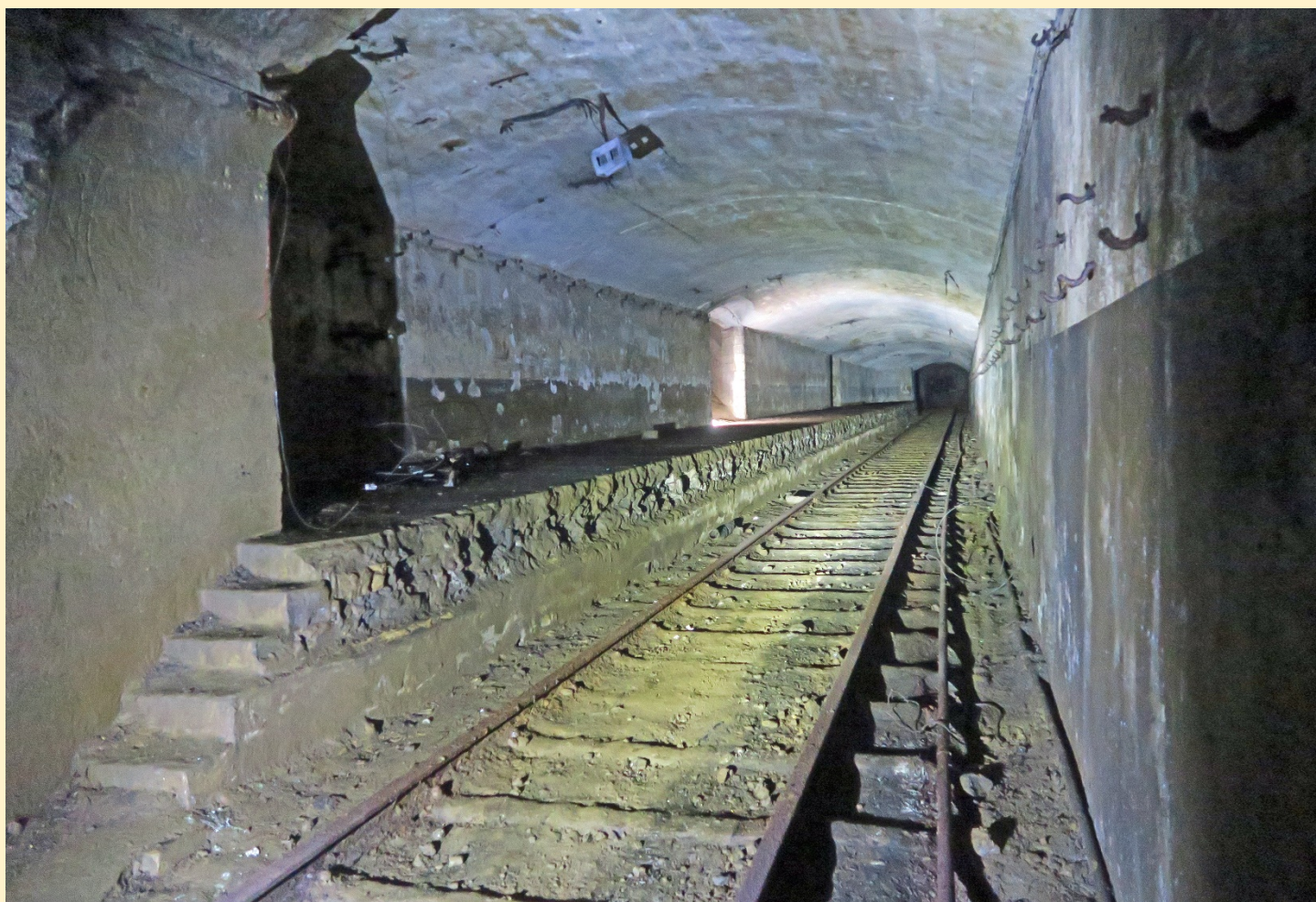
La gare des mineurs d'Haméville : à gauche le quai et les marches permettant au chef de manœuvre de passer de la voie au quai. Son cabinet était à gauche dans l'ombre. On aperçoit dans le mur gauche les deux ouvertures permettant aux mineurs d'accéder au quai - Patrick Etiévant -
