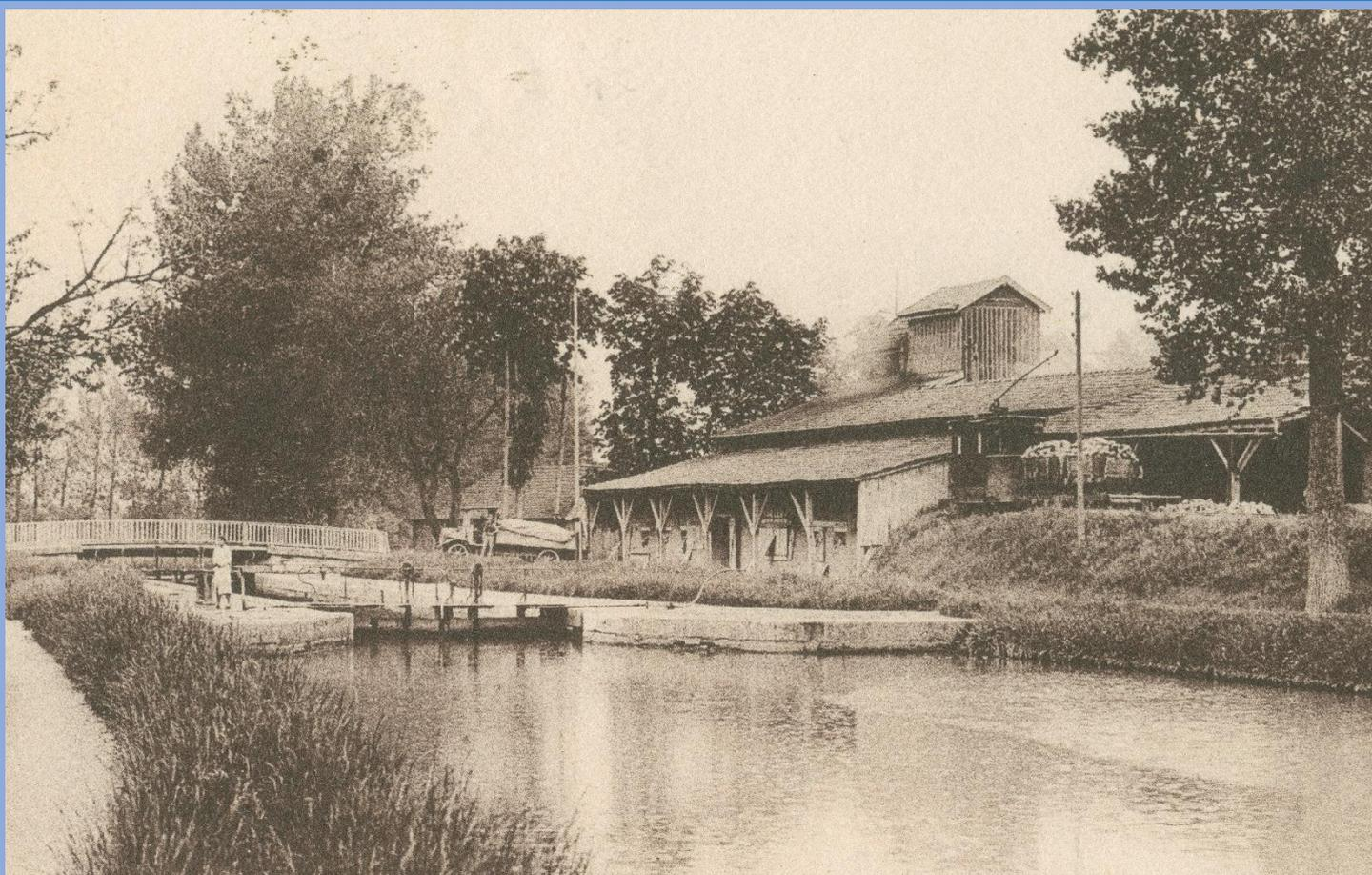
La cimenterie de Marigny-le-Cahouët dans les années 1920. La petite motrice vient d'amener ses deux wagons chargés de pierre au droit de la plate-forme des fours. La voie surélevée vient buter sur les silos, au bord de l'écluse. L'usine s'est dotée d'un camion automobile, dont le chauffeur pose pour le photographe. CPA collection auteur.
