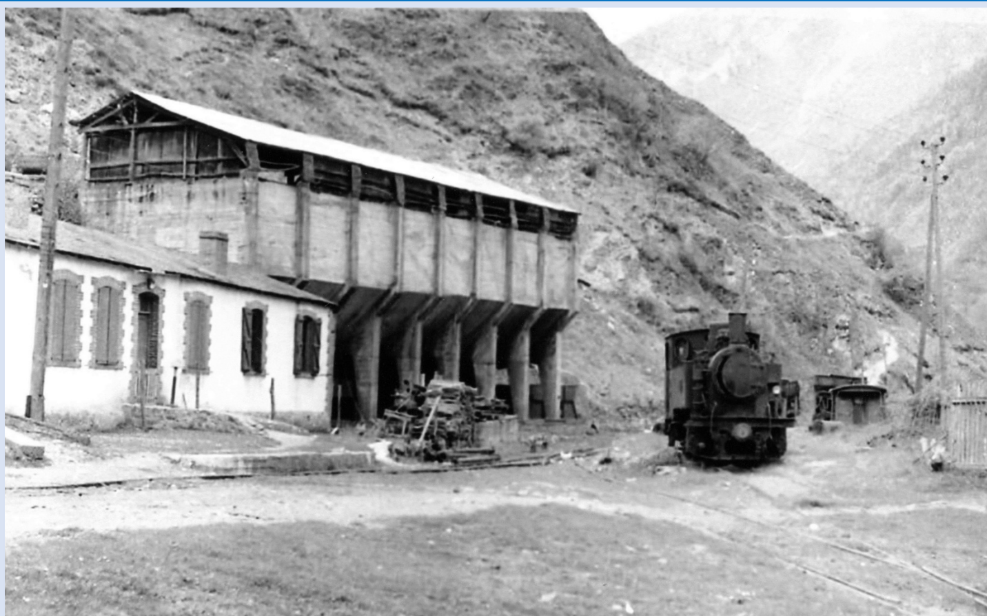
Le silo de chargement de Ferrières, collection B. Capmartin.
