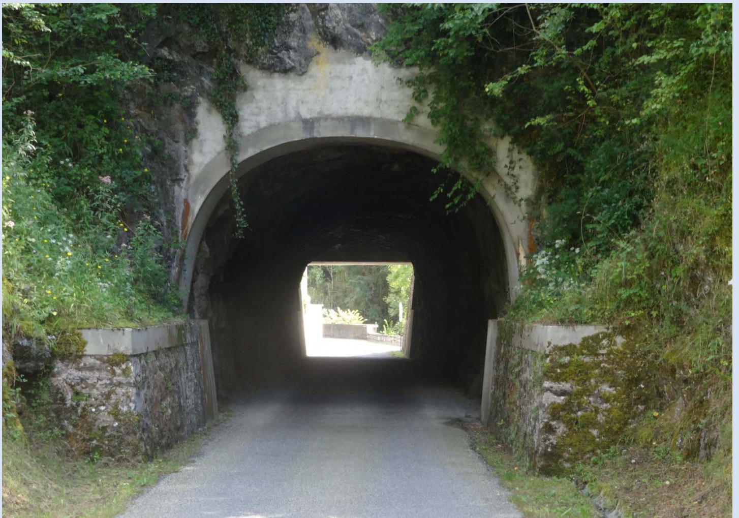
Aujourd'hui : le portail Nord du tunnel de Callibet, photographie M.C. Dupont.
